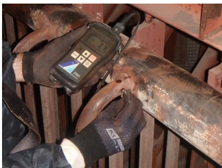
超音波厚さ測定(ボイラースタッフ管)
